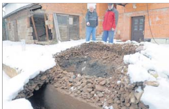
Anwohner stehen an der Erdfall-Stelle in Tiefenort. Foto: Matz
